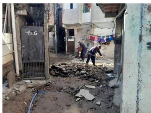
DEMOLIÇÃO DE PISO DE CONCRETO
