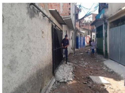
DEMOLIÇÃO DE PISO DE CONCRETO
